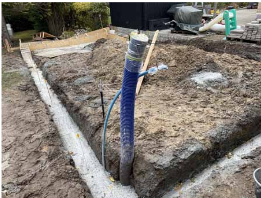
Resultatet af fundamentstøbningen
