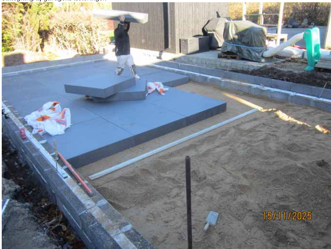
Udlægning af garagens isoleringen
