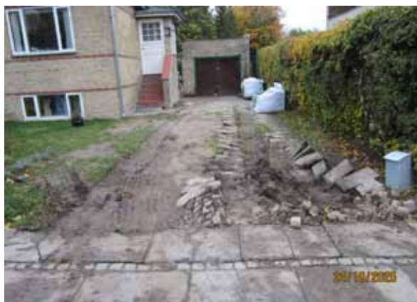
Indkørslen efter besøg af betonbilen
