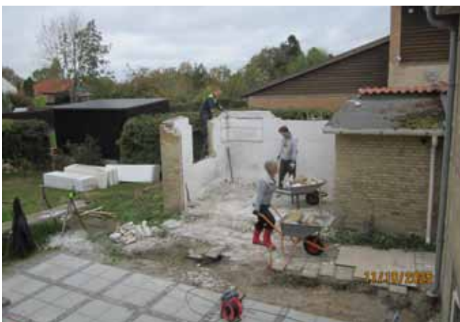
Nedrivning af den lille eksisterende garage
