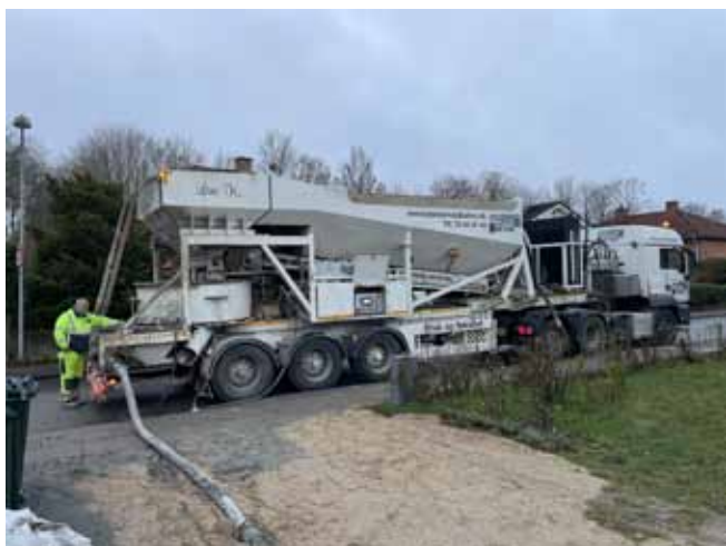
Besøg af en 56 tons betonbil for støbning af gulv
