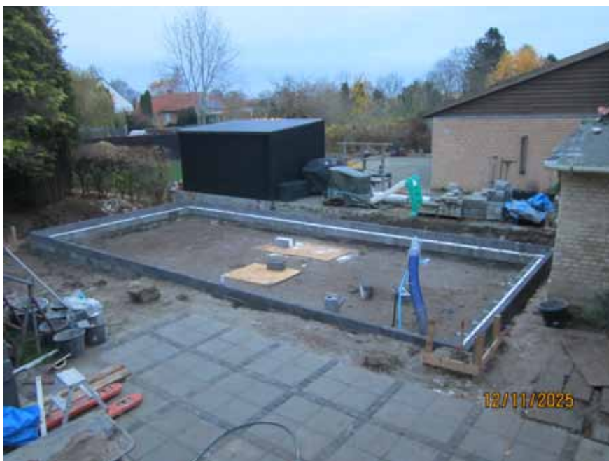
Lecablokke placeret ovenpå fundamentet
