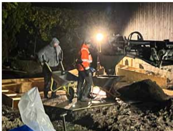
Støbning af fundamentet med færdigbeton
