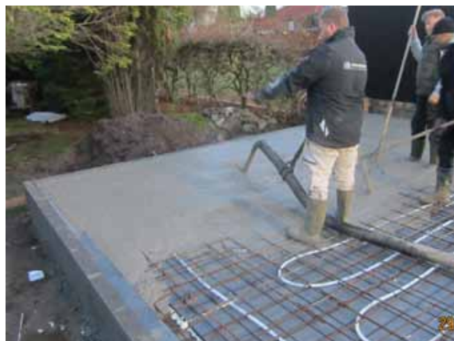
Selve støbningen ovenpå armeringsjern og varmeslange
