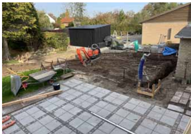
Udgravning til den nye garages fundament
