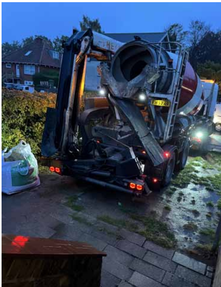
Betonbilen med den nye garages beton til fundamentet
